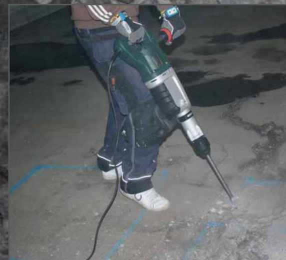
Metabo har en lång maskin som du kan luta mot benet när du bilar för att få en bekväm ställning.
