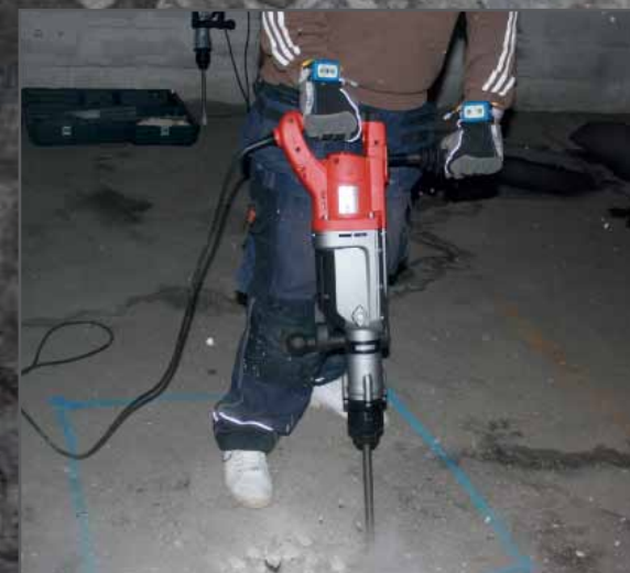
Eftersom du kan avlasta maskinen mot knäet känns inte vibrationerna av så pass mycket som värdena visar.
