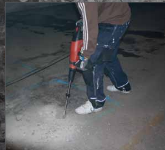
Det är svårt att komma igenom betongen utan att bända och vrída på maskinen när man bilar.
