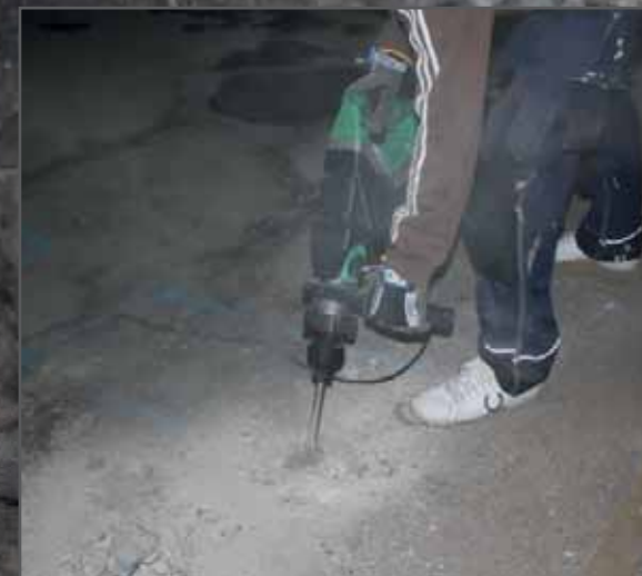
Hitachi är en kort maskin där du inte kan placera något stödhandtag uppe på maskinen, så se till att ha en så lång mejsel som möjligt för att få en bekvämare ställning.
